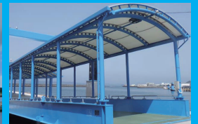
調川港連絡橋上屋
