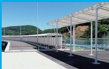
佐世保港浦頭地区通路上屋
