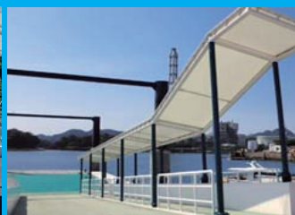
佐世保港相浦地区連絡橋屋根
